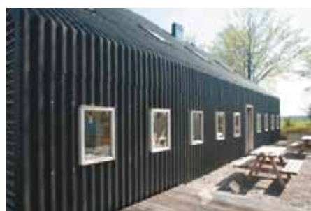
gesloten gevels met kleine ramen
